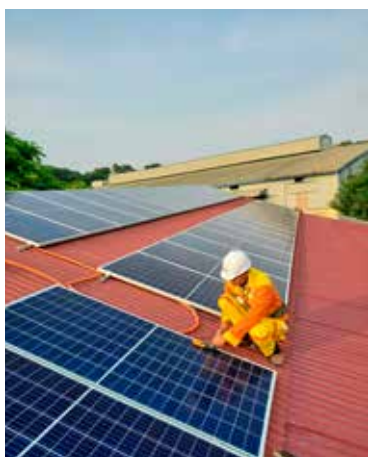
➤ INSTALAREA DE PANOURI SOLARE.
