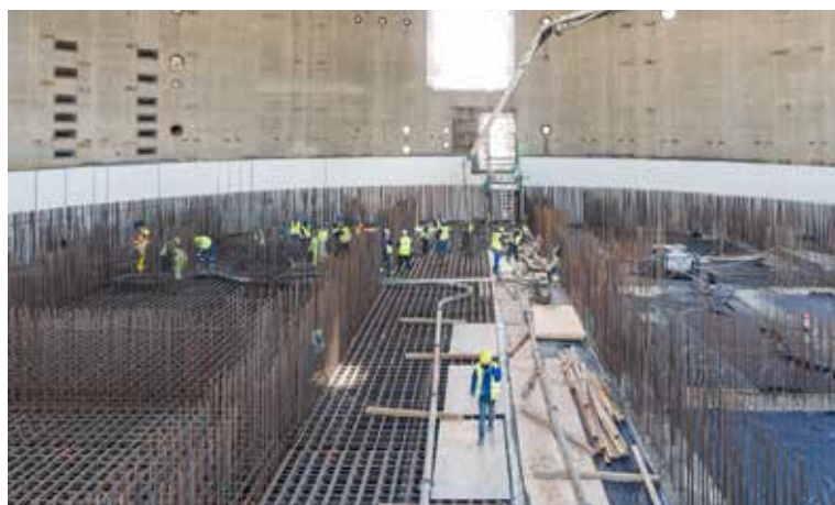
ÎN LUNA MAI NUCLEARELECTRICA A REALIZAT PRIMA TURNARE CONTINUĂ DE BETON AFERENTĂ STRUCTURILOR PERMANENTE DIN CADRUL PROIECTULUI DE RETEHOLOGIZARE A UNITĂȚII 1 CNE CERNAVODĂ. ©NUCLEARELECTRICA.
